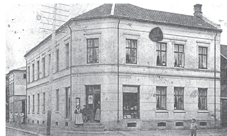
HISTORISK HUS: Lokalene i Tordenskioldsgate 55 i Drammen har huset bakeri, menighet og melkebutikk foruten beboere siden byggeåret 1897.
